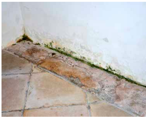
Feuchtigkeitsschäden an den Wänden
