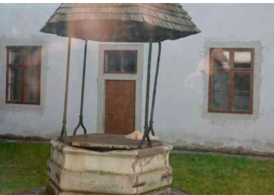
Der Brunnenhof wird renoviert
