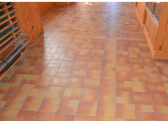
Fliesen werden entfernt
