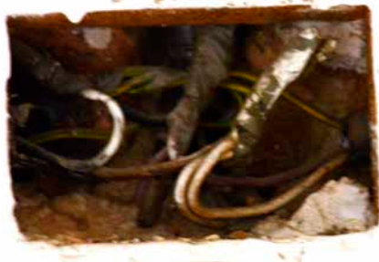
veraltete Elektorinstallation
