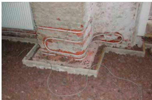
Bauteilheizung wird installiert
